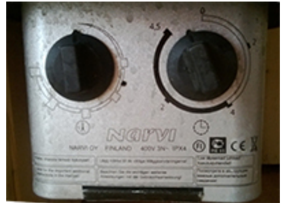
Kytkimistä säädetään haluttu lämpötila ja saunan päällä oloaika kääntämällä kytintä myötäpäivään.
