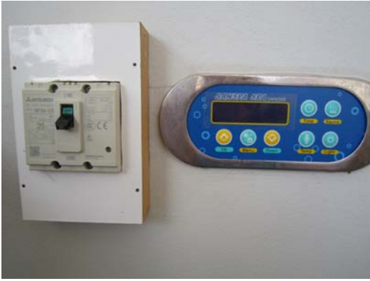
Pääkytkin (ohjauspaneeli ei käytössä).
